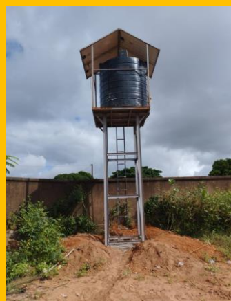
Château d'eau autonome
