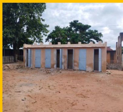
Ré habilitation d'un bloc de latrines
